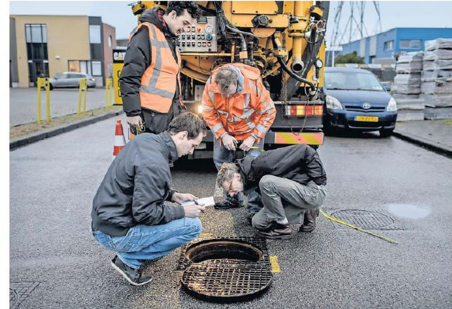
▲ Aan de Stavangerweg wordt de bijna vijftien jaar oude riolering getest. Enerzijds om te kijken naar de staat van het buizenstelsel, anderzijds wordt een nieuwe manier van schoonmaken en onderhoud getest. Foto Jan Zeeman
